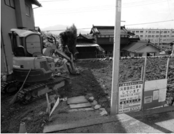
写真1-1 急傾斜地の宅地開発は典型的な「人災」 (土砂災害の被災地の広島市郊外にて)
